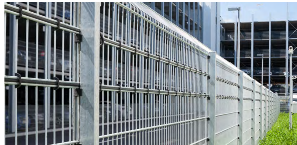
Zaunlinie bestehend aus Dreifachstabmatten mit zwei Kabelführungen
